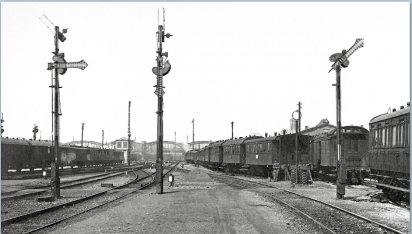
Die Ausfahrt aus dem Münchner Hauptbahnhof um das Jahr 1920 zeigt bayerische Signaltechnik und bayerische Wagen unterschiedlicher Bauarten. An der linken Bildseite ist preußische „Wagenhilfe“ zu sehen, da der bayerische Bestand durch die Reparationsabgaben stark dezimiert war.
